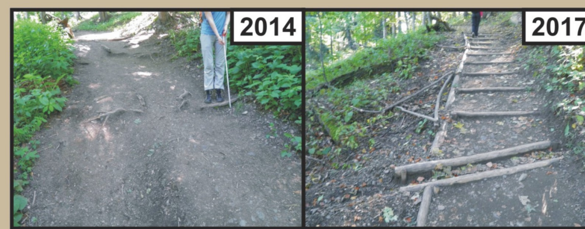
Zastosowanie drewnianych progów, krawężników, przepustów wodnych oraz przeszkód w celu ograniczenia erozji na szlaku Kosarzyska-Polana Pieniny
