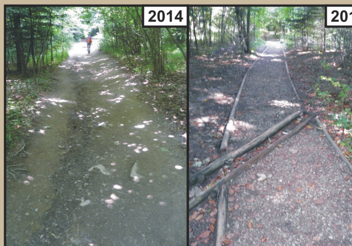
W wyniku renowacji nawierzchni badanego odcinka szlaku Kurnikówka-Wymiarki wielkość erozji została ograniczona do minimalnych rozmiarów
