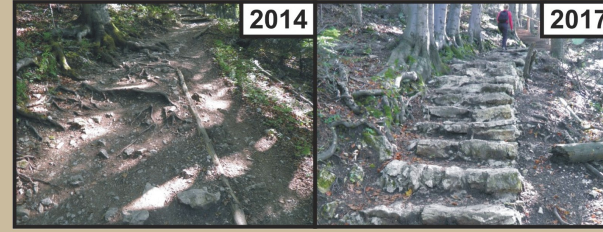
Efekty zastosowania zabezpieczeń przed rozdeptywaniem bocznym szlaku Kosarzyska-Polana Pieniny przez turystów
