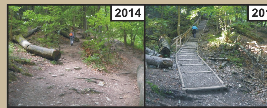
Fragment szlaku Kras - Sosnów o zmienionym przebiegu trasy w celu ominięcia strefy ze zniszczoną nawierzchnią
